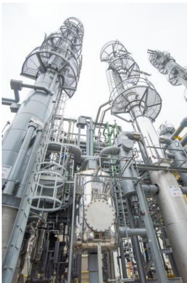
Figure 3.1 : Production d'acétate d'isopropyle utilisant une distillation réactive
